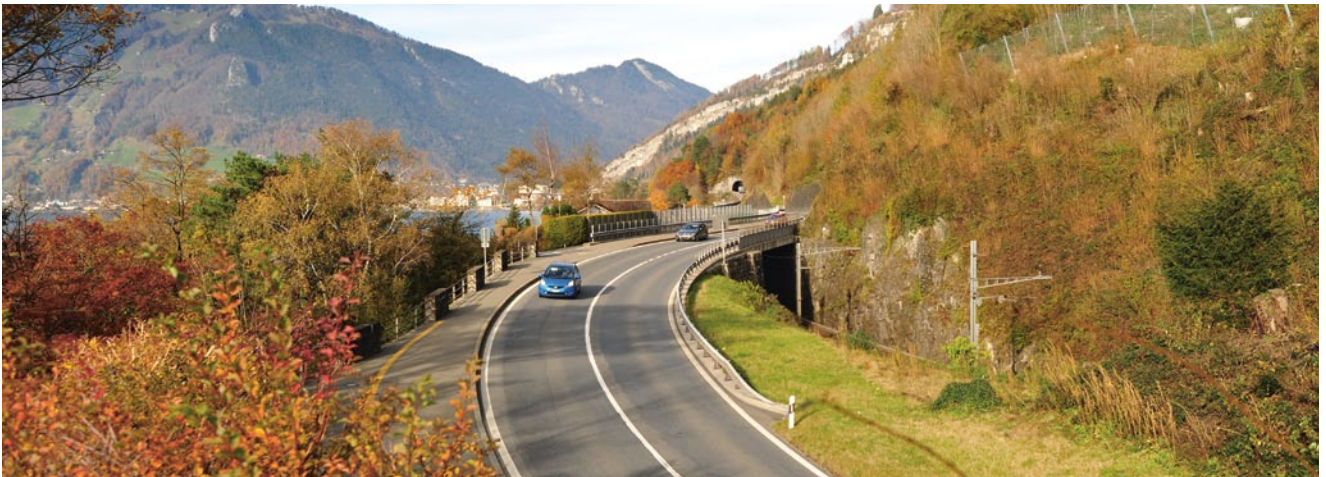
Im Bereich Ort werden die Neue und die alte Axenstrasse zusammentreffen.
