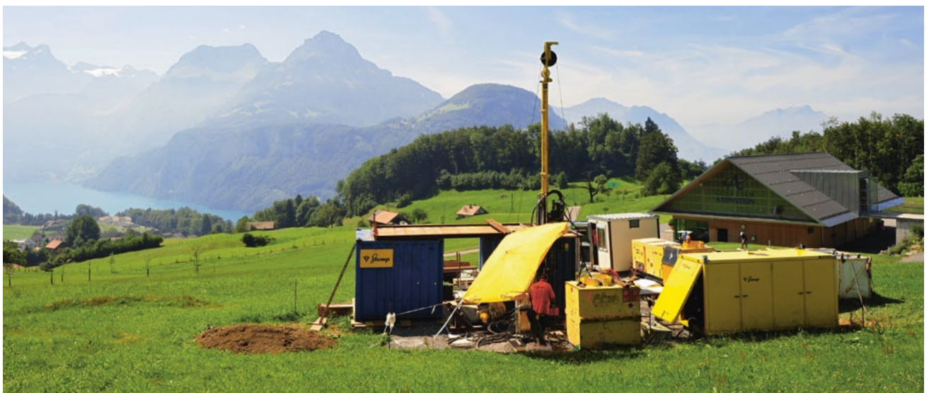
Drei Tiefenbohrungen zur Karst-Erkundung wurden abgeteuft, eine davon in Morschach.
