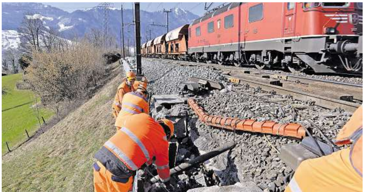
Mitarbeiter der Firma Vanoli bauen hier bei Steinen die Gitterroste ein. Bild Erhard Gick
