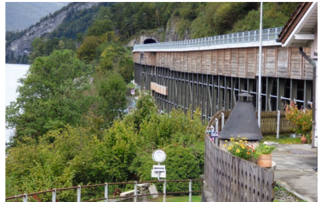
Der Sicherheitstunnel für die SBB-Strecke an der offenen Strecke Ort wurde bereits erstellt.
