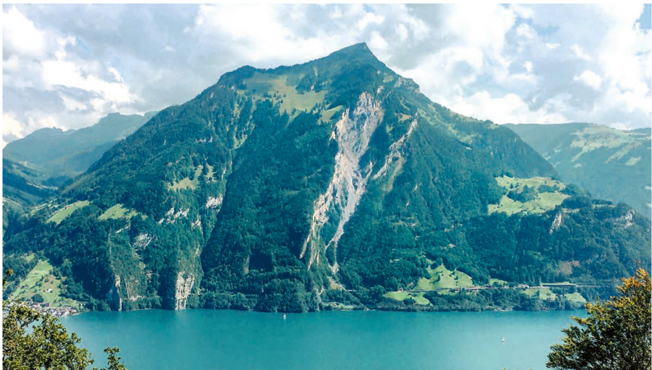
Das Gumpischtal mit seiner Runse zwischen Sisikon (links) und der Tellsplatte (rechts). Das Viadukt der Axenstrasse und der Ablenkdam (vgl. auch Bild oben) queren das Tal im unteren Bereich.
