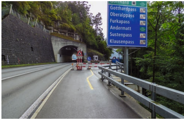
Bei Steinschlag schaltet die Ampel an der Kalotte im Tunnel auf Rot. Bei längerer Strassensperrung können die Fahrzeuge auf der Verbreiterung wenden und die A2 über Nidwalden nehmen.
