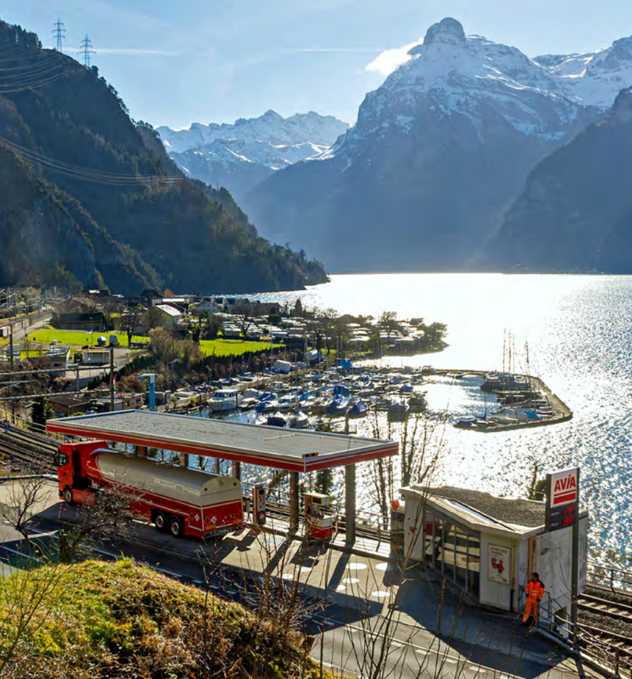
Nach dem Rückbau der Tankstelle wird in diesem Bereich der Installationsplatz Dorni geschaffen.
